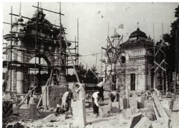
Ouvriers travaillant à la restauration d'un pavillon et du portail, 1924 Musée franco-américain du château de Blérancourt © RMN-GP / H. Bréjat
