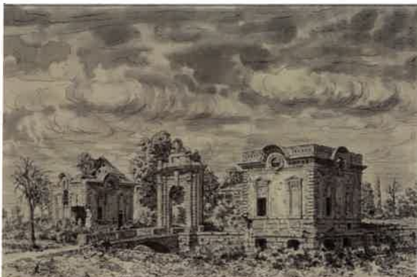
Paul Ledoux (1884-1960), Le château de Blérancourt en 1910 . Sur cette vue, seules subsistent les ruines de la porte monumentale et de des deux pavillons d'angle.
